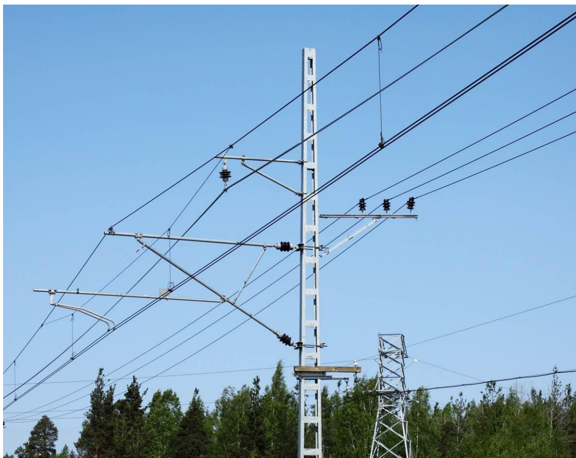
Рис 1. Контактная подвеска КС-200-06-К
